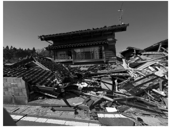
【写真2】倒壊した家屋(珠洲市蛸島)
