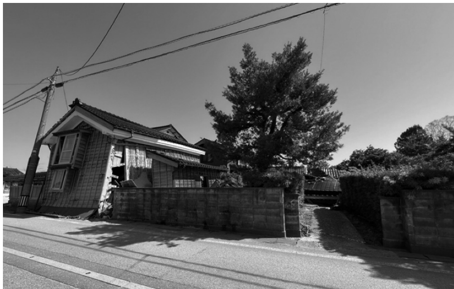
【写真1】右奥の主屋が倒壊、左の土蔵が傾く(珠洲市正院)
