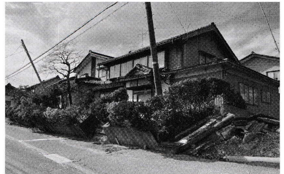
【写真4】内灘町の西荒屋の建物被災例
