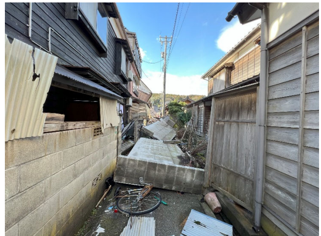
写真1 輪島市鳳至町の被災状況
