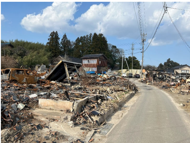
写真2 能都町白丸の津波&焼失区域の状況
