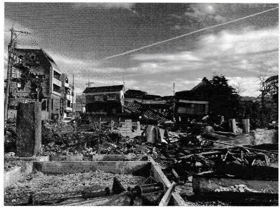
[写真1] 火災の延焼区域。手前と左側の延焼区域と奥方向に延焼を免れた区域を示している。手前からは空地(駐車場)の存在、左側からは道路空間と消火による効果で延焼が阻止されたと推定されている
