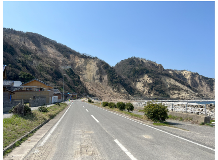
写真1 珠洲市仁江地区の土砂崩壊 輪島市方向への国道249号線のトンネルが完全に埋没 左側に集落、右側に白く隆起した海岸が見える。 2024年4月13日撮影
