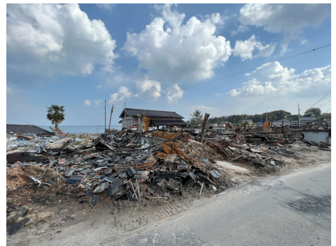
写真2 能登町白丸地区（津波浸水&火災焼失） 2024年3月14日撮影
