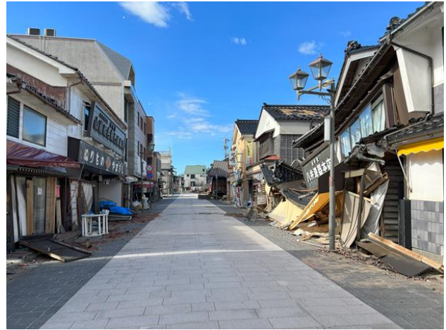
写真1 輪島市朝市通り商店街の被災状況
