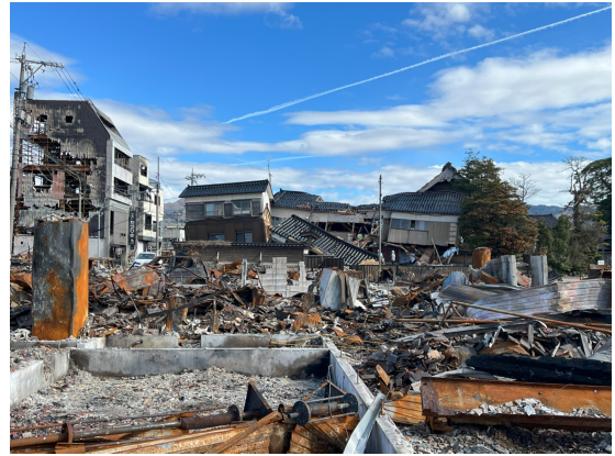
写真1 火災の延焼区域
