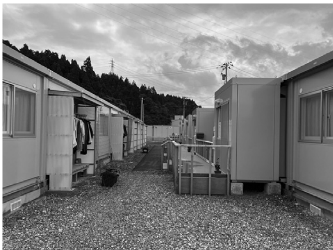
[写真1] 応急仮設住宅(プレハブ式、穴水町)
