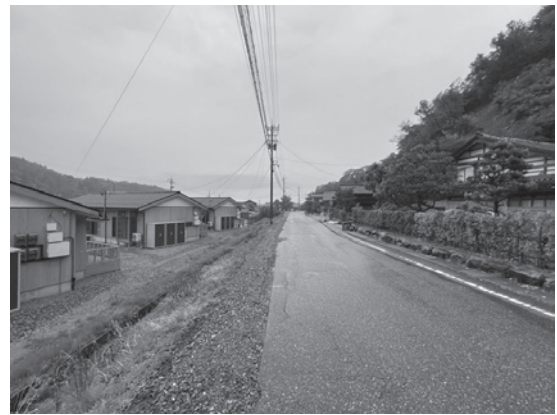
【写真3】木造型(輪島市南志見の里町第2団地)
