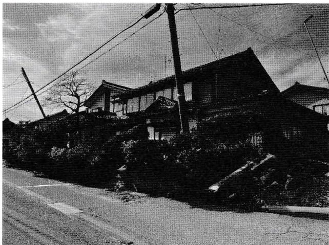
写真3 内灘町西荒屋の液状化&側方流動による被災例
