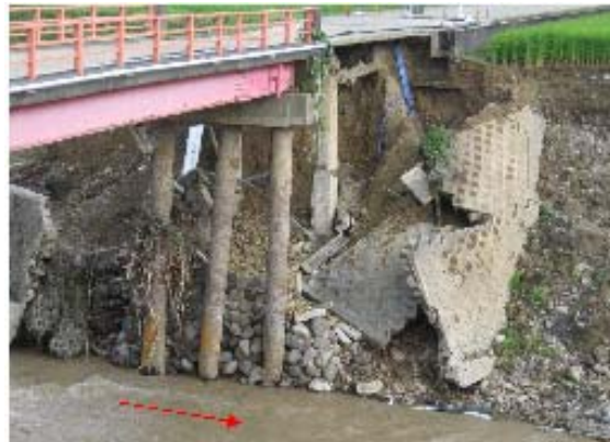
架け替えとなった2橋：左 湯涌荒屋橋 橋台の杭基礎が露出している(石川県提供)
