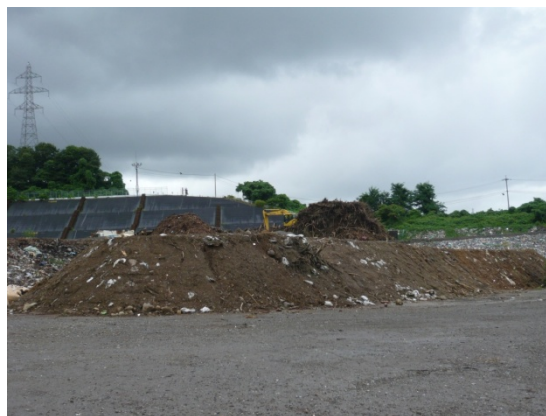
写真 8-6 仮置きされた土砂 その
