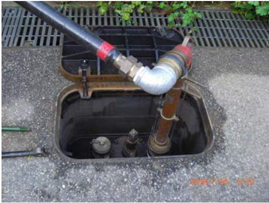
写真6-4 消火栓からの仮設スタンドへ
