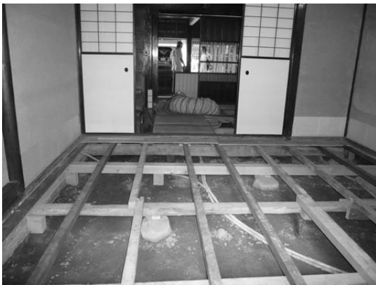
写真5-18 床下の乾燥(観音町・旧涌波家) (9)
