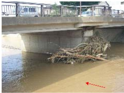
左 中の橋 上流側桁隠しがほとんどもぎ取られている。流水および流木衝突によると考えられる。
