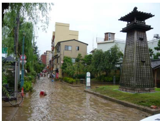
写真4-11 中流部（並木町）被害
