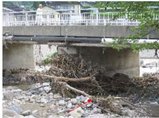
左 茅原橋 流木が引っ掛かって、高欄が損傷している。路面に土砂堆積。(石川県提供)
