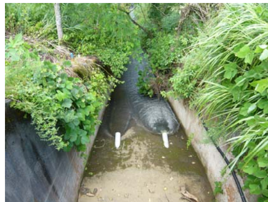
写真4-4 上流部（湯涌温泉貯水池排水路）の状況
