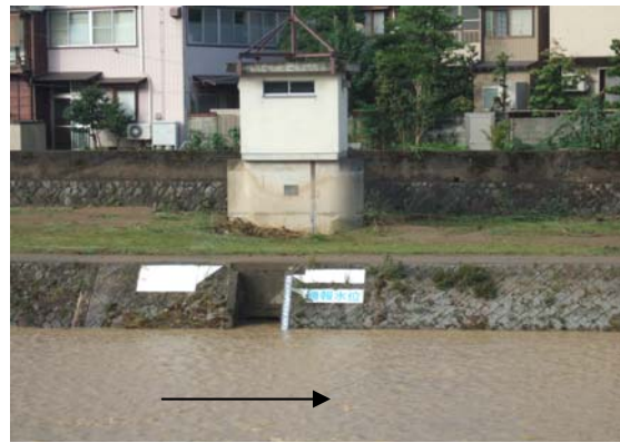
(h) 天神橋水位観測所の水位痕跡
