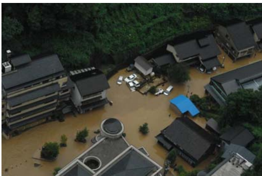
写真4-3 上流部（湯涌温泉）被害*
