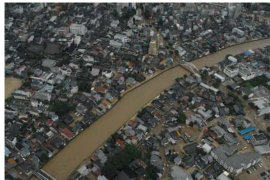
写真4-18 中流部（昌永橋～中島大橋）被害*
