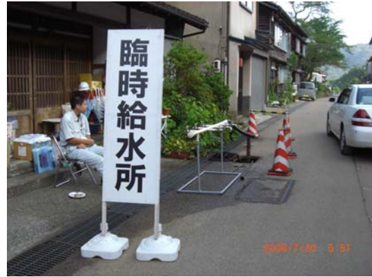
写真6-5 仮設スタンドによる臨時給水所
