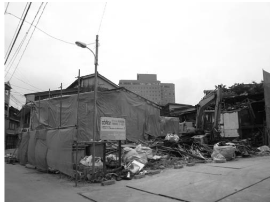
写真5-19 除却された被災町家(橋場町) (10)
