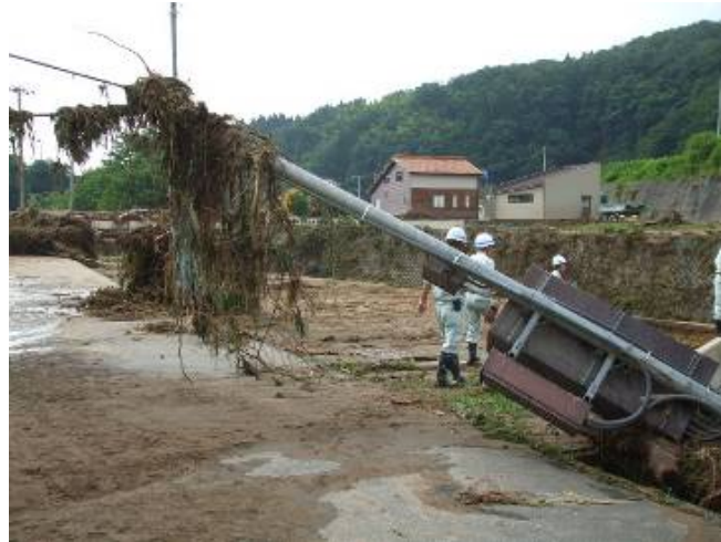
写真6-6 北陸電力の電柱の転倒による芝原第1マンホールポンプ場制御盤の倒壊
