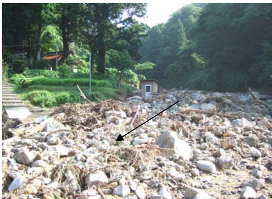
(a) 板ヶ谷町の谷川の土石堆積の様子
