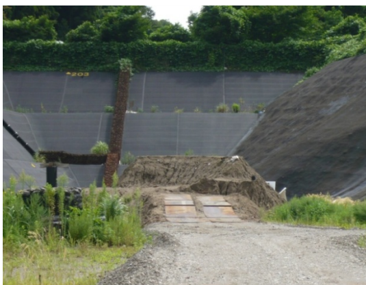
写真 8-5 仮置きされた土砂 その 1 2
