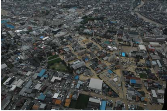
写真4-19 中流部（浅野町校下）被害状況*
