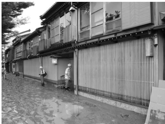
写真5-1 主計町における床上浸水の状況 (1)
