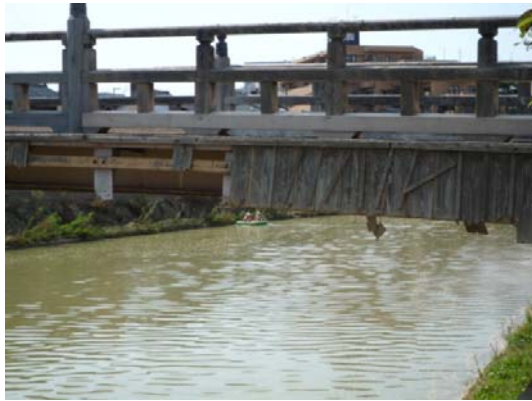
左 中の橋 上流側桁隠しがほとんどもぎ取られている。流水および流木衝突によると考えられる。
