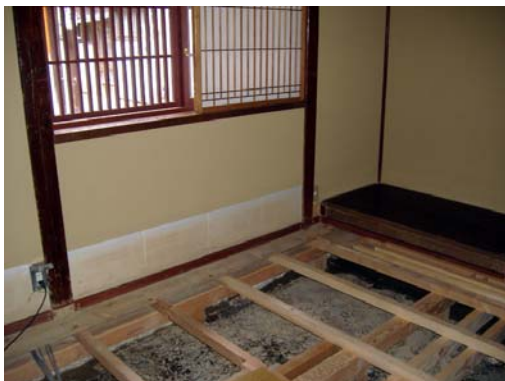
写真5-14 畳を上げ、荒床を外す
