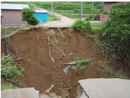
写真6-7 北袋第1圧送管の折損
