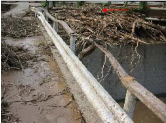
左 茅原橋 流木が引っ掛かって、高欄が損傷している。路面に土砂堆積。(石川県提供)
