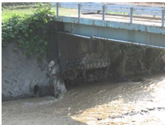
架け替えとなった2橋：左 湯涌荒屋橋 橋台の杭基礎が露出している(石川県提供)
