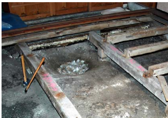
写真5-16 床下にあった吸い込み口
