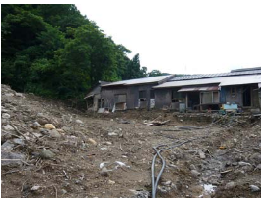
写真4-5 上流部（板ヶ谷町）の被害
