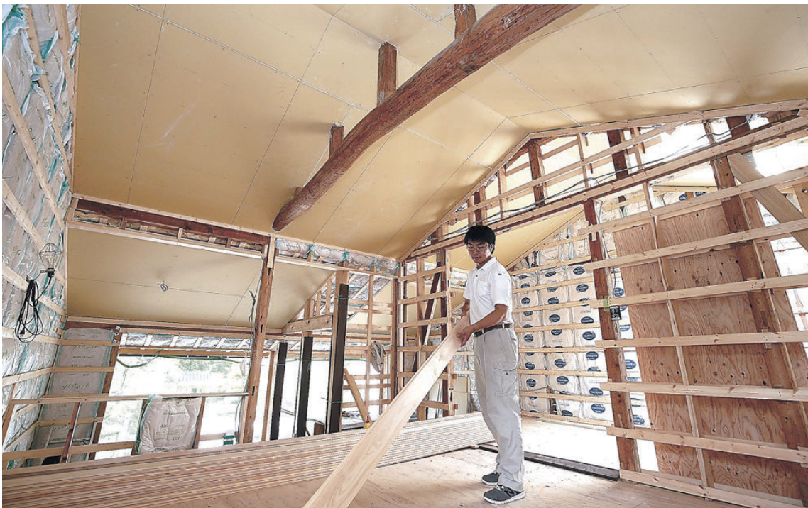
緑地を望む棟続きの町家で改修作業に励む松原さん—金沢市天神町2丁目
