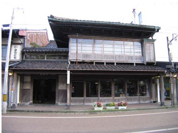
写真 6 改修を受けていない雁木
