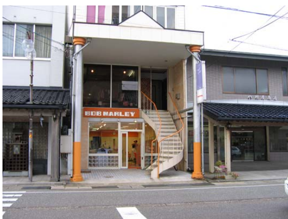
写真 11 雁木の連続性を失わせる建物
